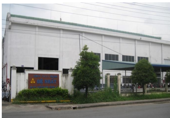
Dự án nhà máy Hóa Nhựa Đê Nhất
