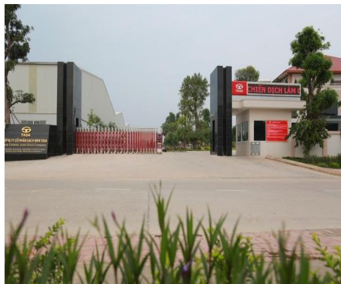
Dự án nhà máy gạch men Tasa giai đoạn 2
