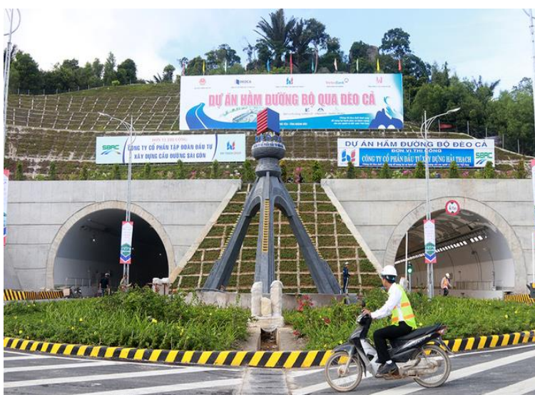
Dự án điện hạ tầng hầm Đèo Cả, Phú Yên.
