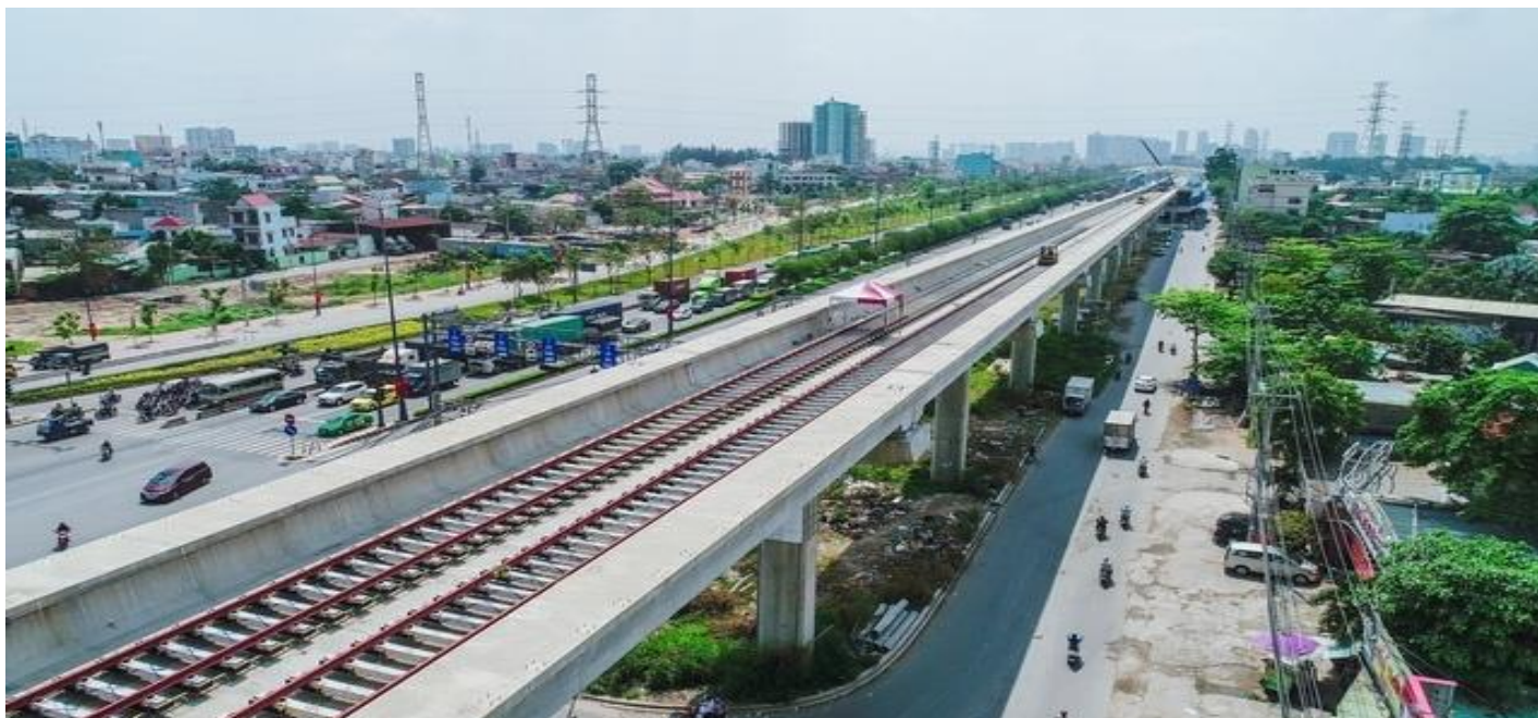
Dự án tuyến tàu điện ngầm Bến Thành – Suối Tiên
